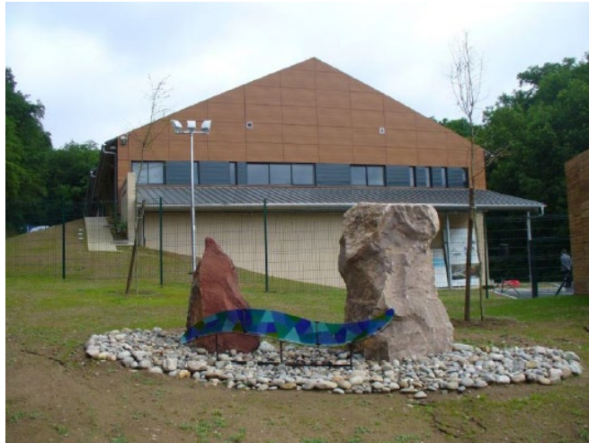
Photographie de la façade de l'usine de la Grèze
