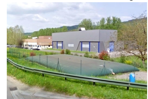
Bâtiment d'activité dans la ZI d'Estresse à Beaulieu-sur-Dordogne
