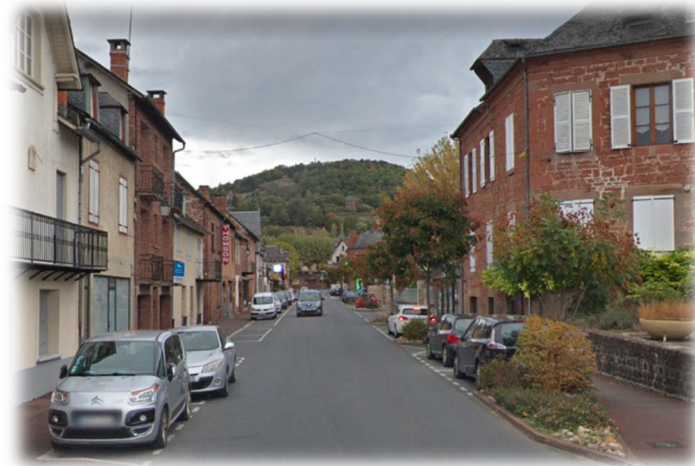
Réseau de trottoirs sur Meyssac, le long de la RD 14
